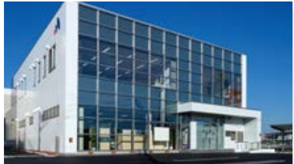
災害時対応型店舗(土浦支店)
