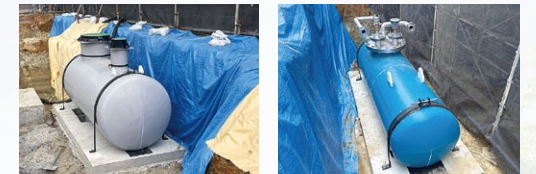
災害時トイレ 2基 水洗トイレが使用できない時のための緊急用災害トイレです。 災害時給水タンク1,000L 1基 災害発生時、500mlペットボトル2,000本分の飲料水を確保しています。
